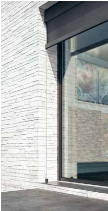
Cavi in acciaio Steel cables
